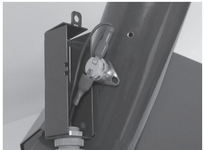
Abb. 10 - Sicherheitsthermostat am Rohr für Pelletzufuhr 95°C
