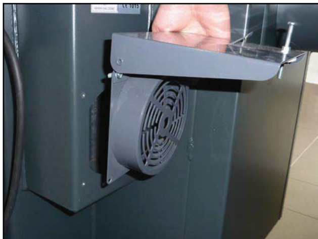
Demontage der Klappe für die Zuführung von Verbrennungsluft
