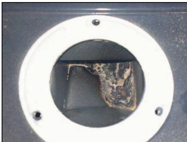
Zerkleinerte Pellets und hohe Staubmenge nach 3 Betriebsmonaten
