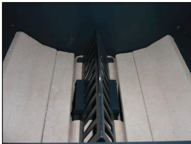
Beispiel des Anordnung des speziellen Rosten auf dem Vergasungsrost des Kessels DCxxRS
