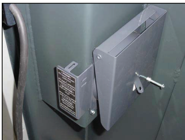
Geschlossener Schieber und geschlossene Regelklappe bei der Pelletsverbrennung
