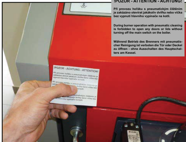
Aufkleber mit wichtigen Hinweisen (ACHTUNG – Während Betrieb des Brenners mit pneumatischer Reinigung .....)
