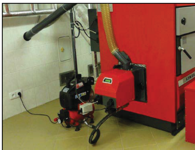
Anordnung des Verdichters neben dem Kessel
