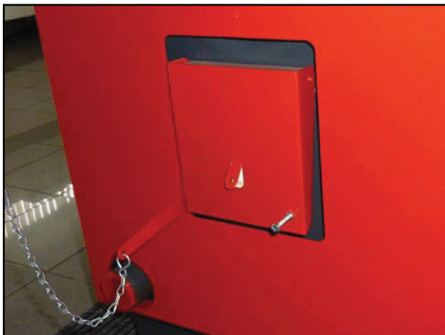
Geschlossene Klappe für die Zuführung von Verbrennungsluft am Kessel DxxP
