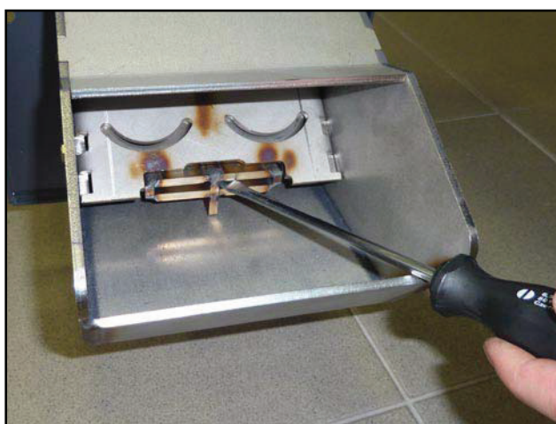
Reinigung des vorderen Bereichs des Kanals für die Druckluftzuführung
