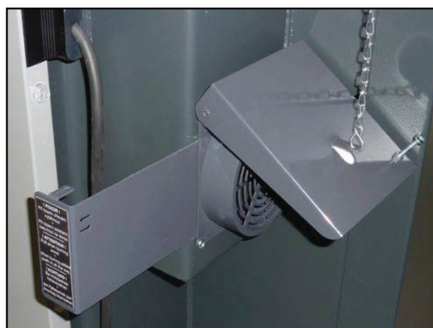
Geöffneter Schieber und geöffnete Regelklappe bei dem manuellen Zulegen des Brennstoffs
