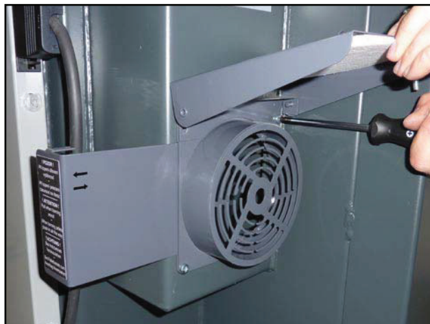
Montage des Schiebers unter die Klappe mit dem Gitter
