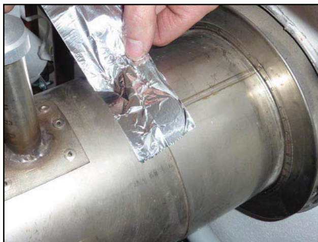
Abdichtung des Rauchabzugs mit Aluband
