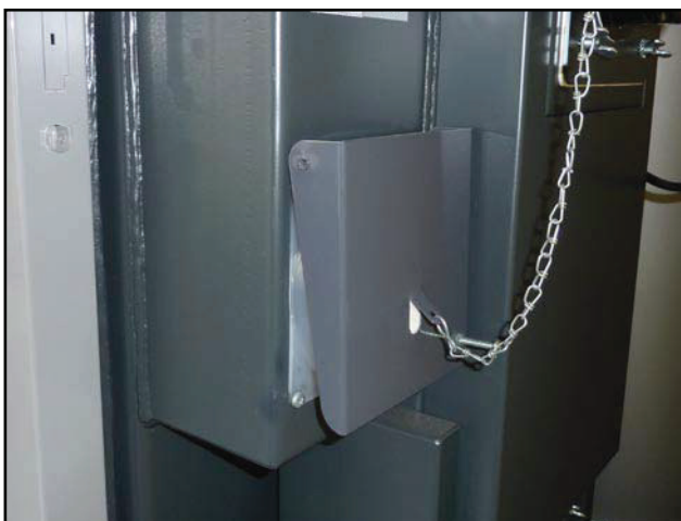
Geschlossene Klappe für die Zuführung von Verbrennungsluft am Kessel DCxxSP
