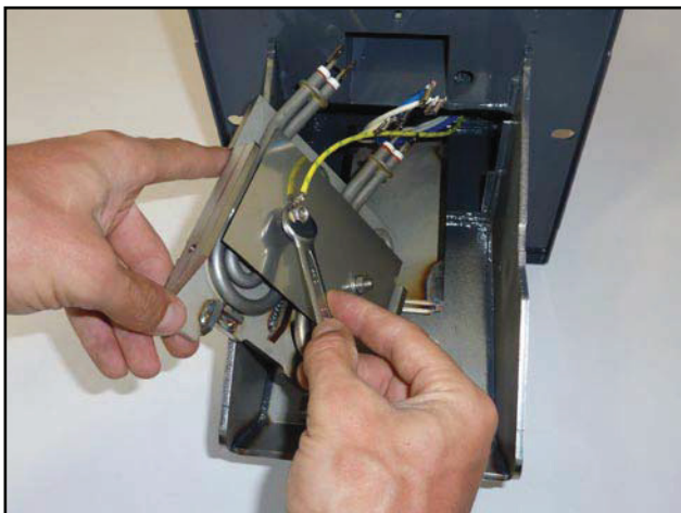
In den Brenner wird die neue Platte für die Glühspiralen eingebaut und der grün/gelbe Leiter unter eine der Mütter befestigt
