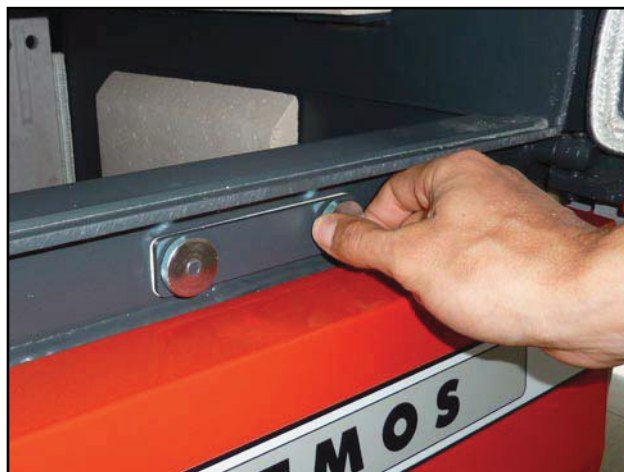
Nachgezogene Kappe der zusätzlichen Sekundärluft am Kessel DxxP
